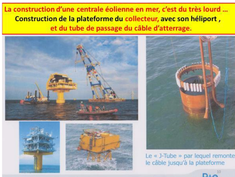
Figure 7 : construction de la plateforme du collecteur, équipée d'un hélicoptère, et installation du tube de passage du câble d'atterrissage.
