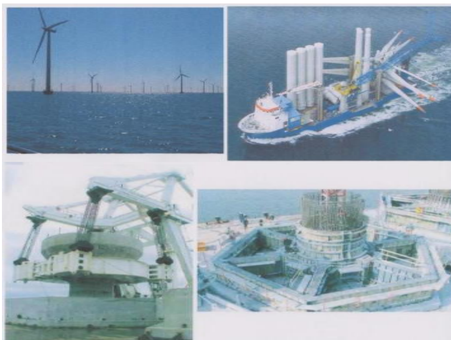
Figure 6 : L'implantation d'éoliennes en mer. En haut : à gauche, vue d'une centrale éolienne, à droite, barge de pose où on distingue les embases, les mâts et les rotors. En bas, création des fondations. Documents WPD.
