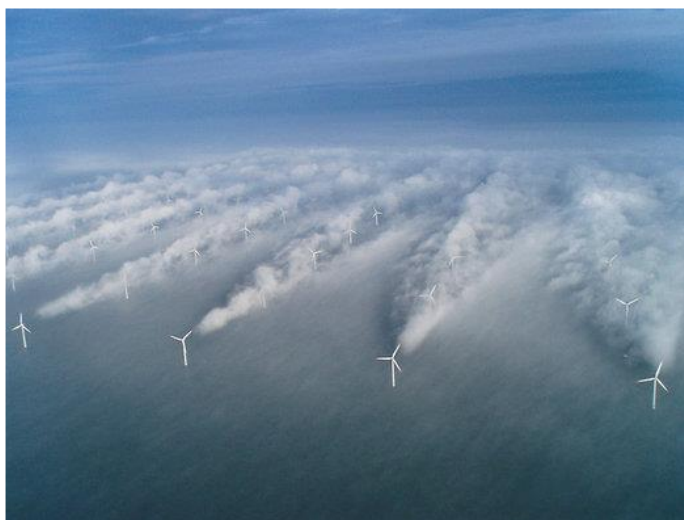
Figure 17 : traînées de la centrale danoise Horns Rev 1, montrant les turbulences derrière les éoliennes. Source : Vatenfall
