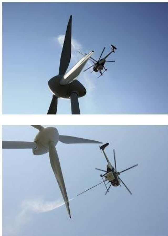
Figure 21 : Nettoyage des pales d'éoliennes par détergents à la lance Haute Pression et par hélicoptère.
