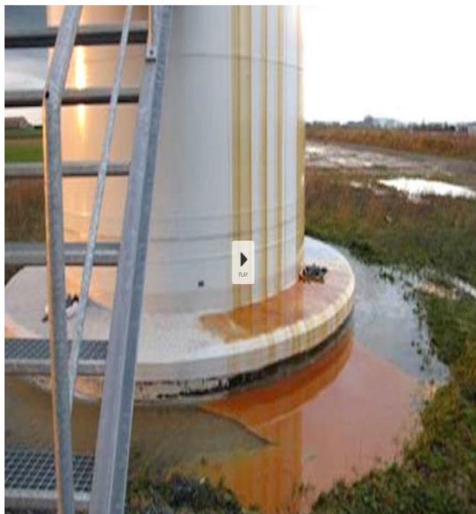
Figure 22 : Fuite d'huile depuis une nacelle sur une éolienne terrestre en 2012 à Leuze-Europe en Belgique.
